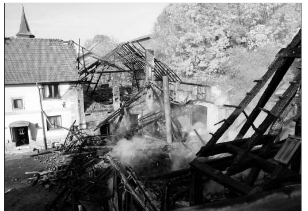
Von der ehemals stattlichen Scheune des Anwesens von Konrad Hahn ist kaum etwas übrig. Die meisten Trümmerteile hat ein Bauunternehmen schon weggebracht. Foto: Winfried Möller
